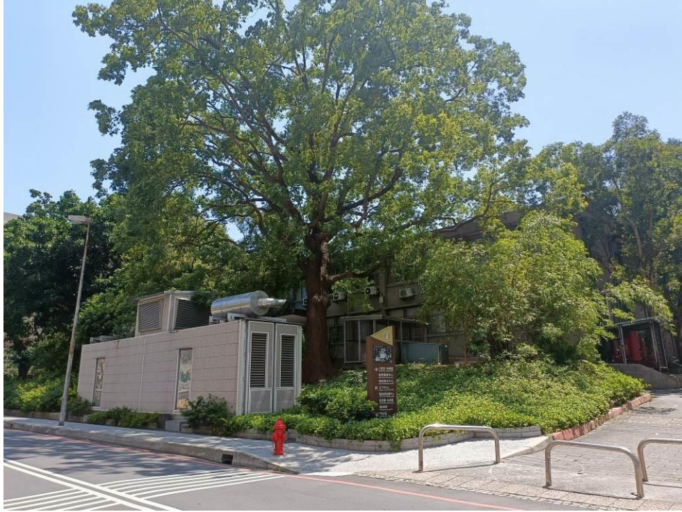
圖 1.2-4 基地現況中正樓東北側既有舊資訊室
