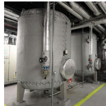
鍋爐外包覆層示意圖(取自網路)
